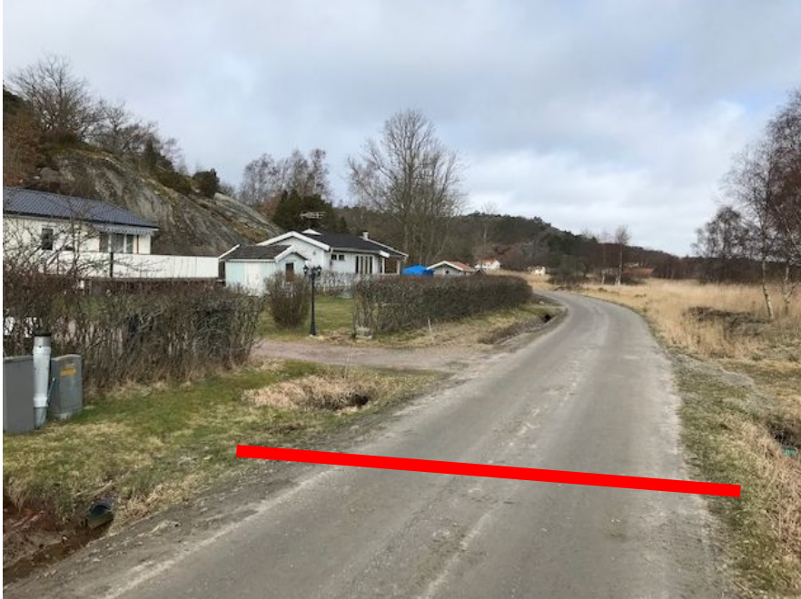
Farthinder mellan Nedre Tådås 40 och 42 framför elskåp
